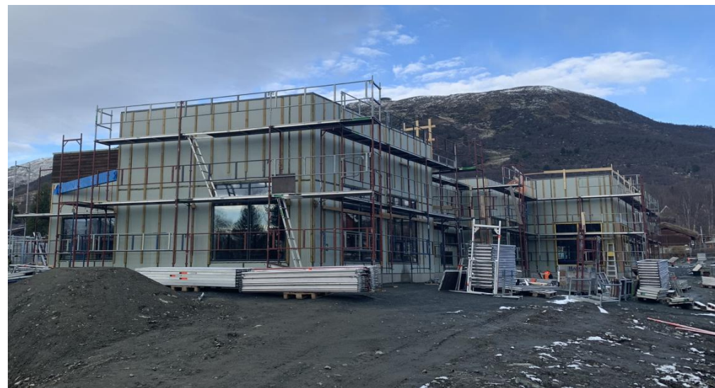
Høgmo barnehage under bygging
