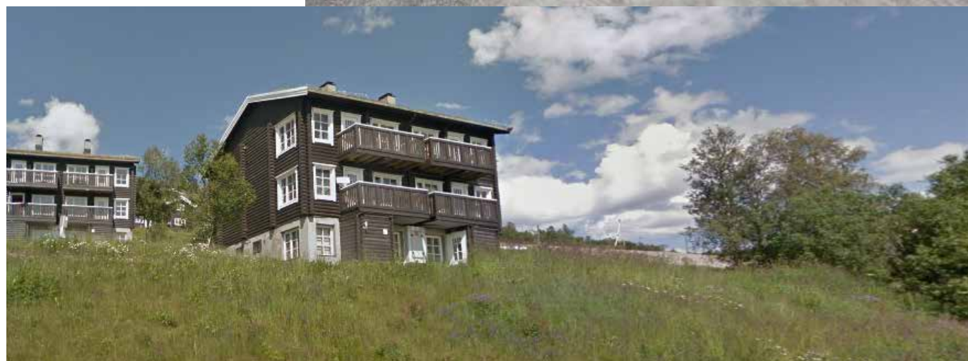
Det ligger et eksisterende bygg, avgrenset av samme veger. Øverst: sett fra adkomstvegen nord for planområdet. Nederst sett fra sør.
