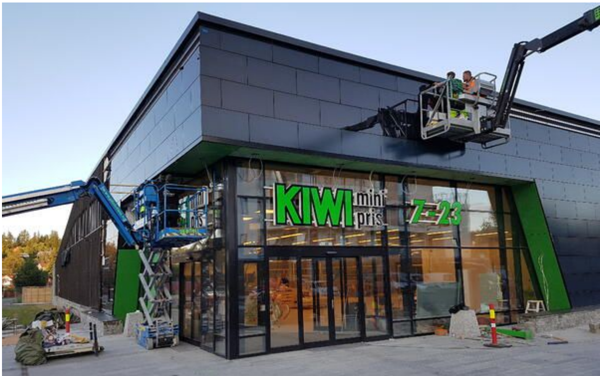
Figur 10. Eksempel på montering av solceller på vegg ved Kiwi Dalgård. Foto: FUSen AS
