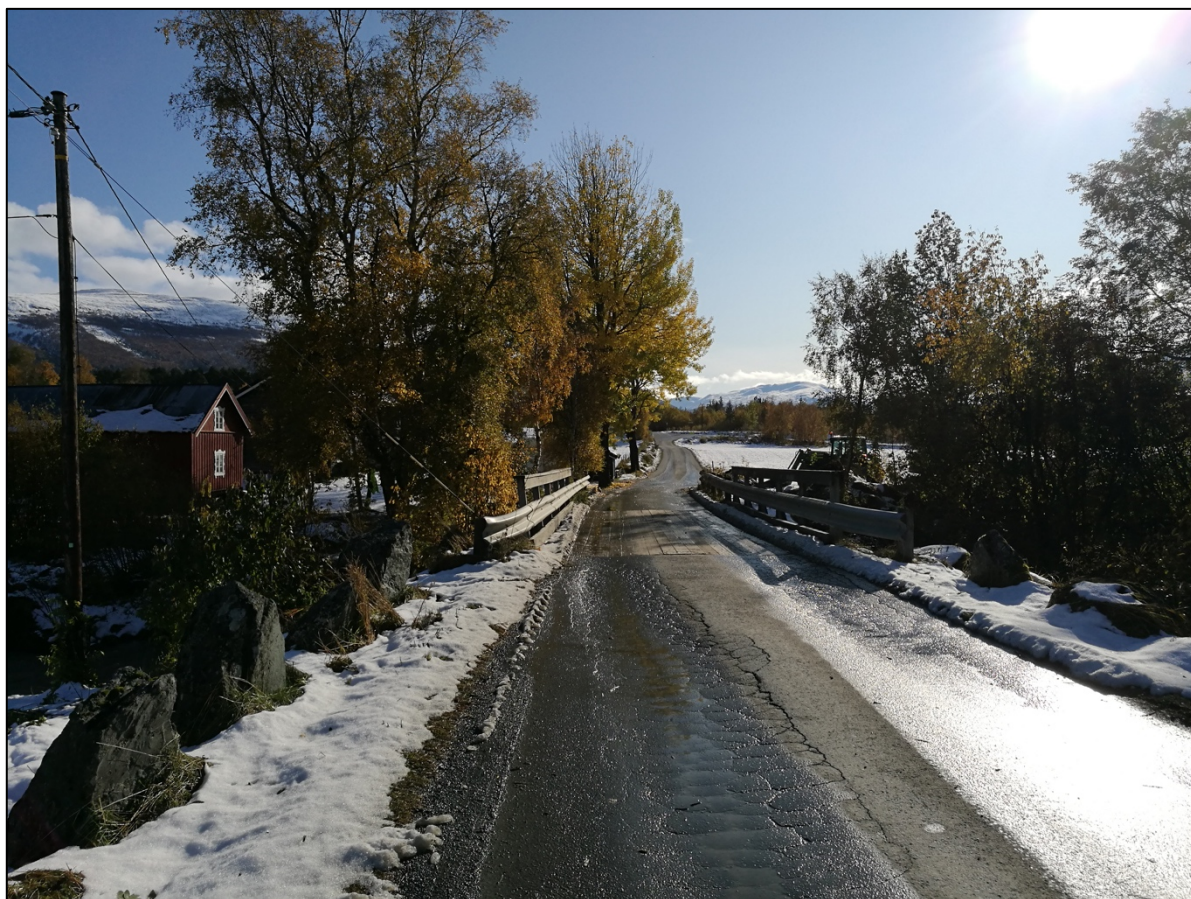
Ålmvegen, ved brua over Ålma, oktober 2019. Vegen har ett kjørefelt.
