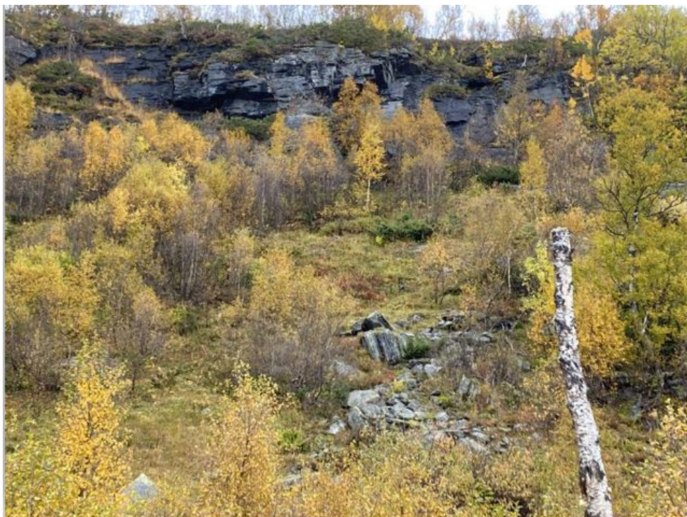
Figur 26. Omtalt bergskrent øverst i påvirkningsområdet. Det ligger stedvis en del blokker like under bergskrenten. Det ble ikke observert ferske utfall. Terrengoverflaten har god demping. Tatt ved infopunkt nr.16.
