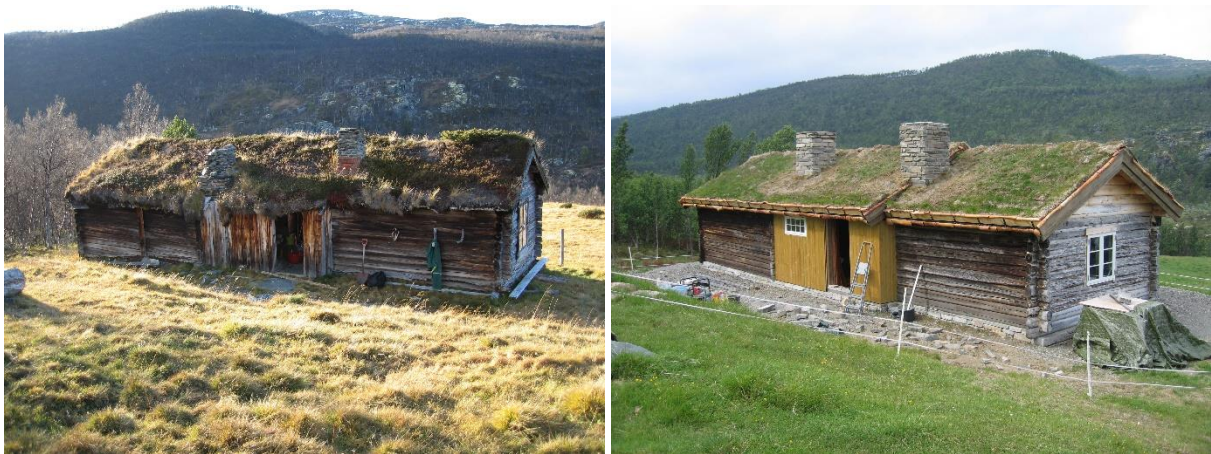
Eksempel på istandsetting av sæterbygning. Før til venstre, etter til høyre.
