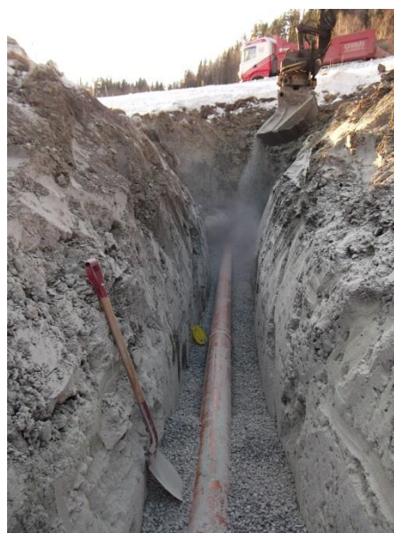
Figur 5 Etablering av ny ledning
