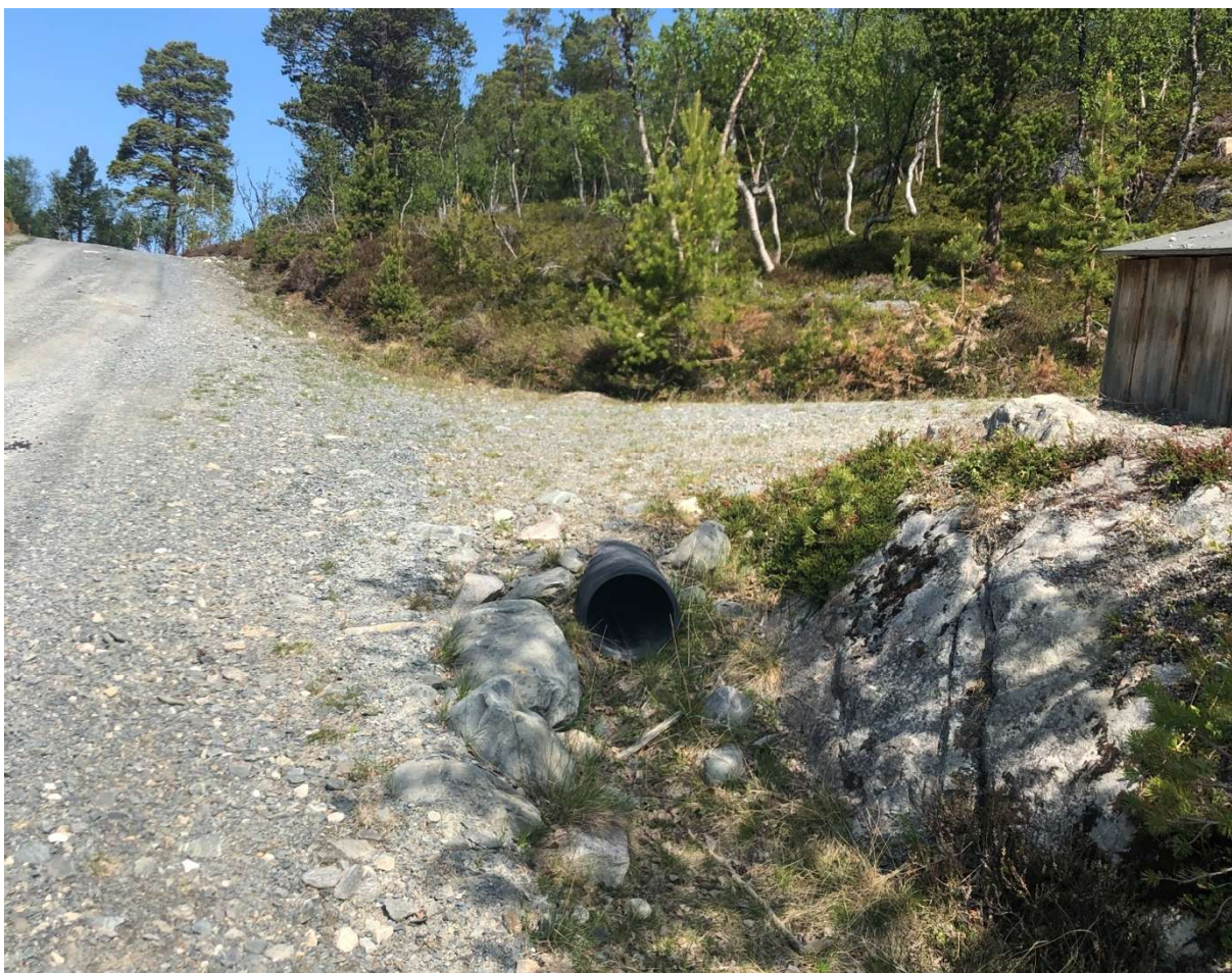
Figur 14 Grytdalsvegen. Avkjørsel med stikkrenne. Grusoppbygging og grøft
