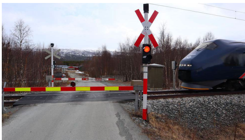
Jernbaneovergang ved Revmo nord for Oppdal sentrum (foto: Per Ole Aalberg, OPP).
